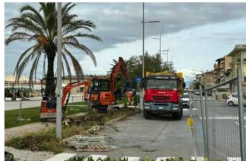
I mezzi impiegati per i lavori di riqualificazione della Ciclovia Tirrenica ieri mattina all'opera nella frazione costiera di Lido di Camaioire
